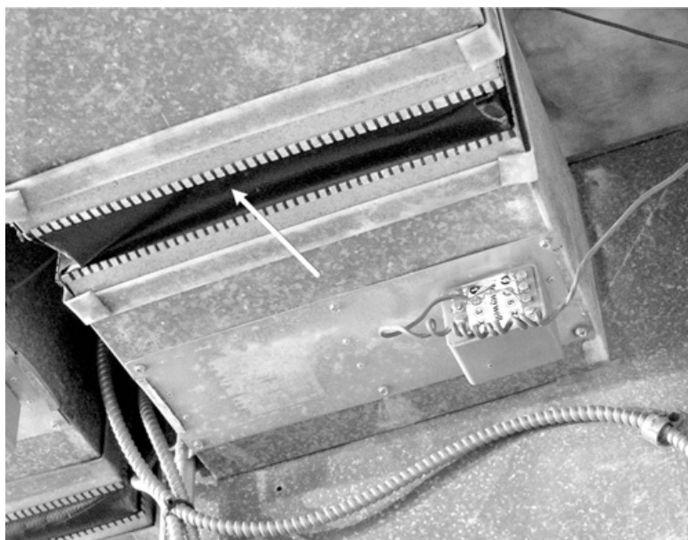
Hình 20.11: Bộ tách cao su gắn trực tiếp vào ống dẫn khí kim loại để ngăn rung động của lò truyền đi khắp nhà.
